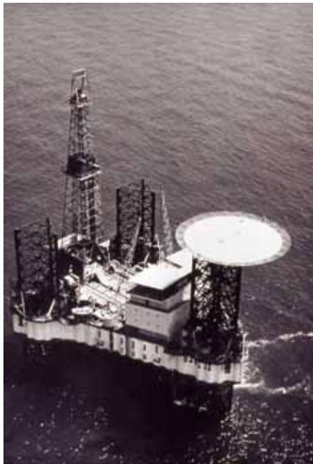
Figura 2. La piattaforma "Paguro" sul sito di perforazione (archivio ENI-Divisione).
